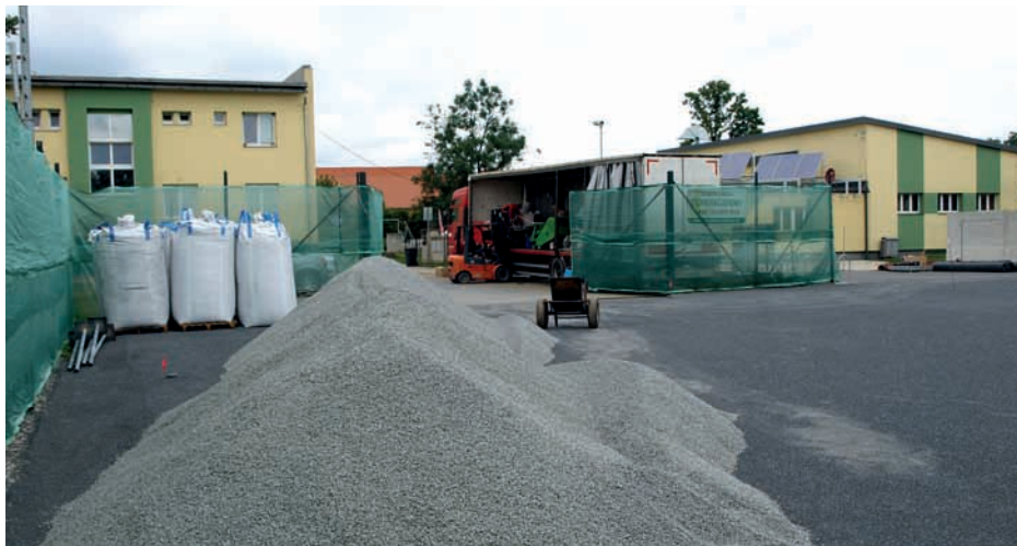
Rekonstrukce tenisových kurtů
